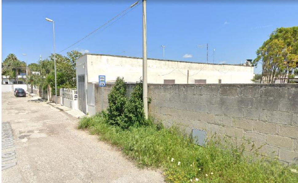
Figura 74 - Fermata Via Masseriola
